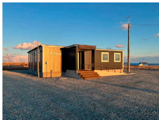
● 湯沸会館新築工事
