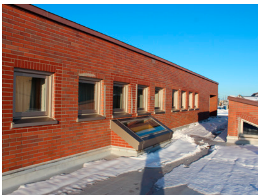
● 霧多布保育所改修工事
