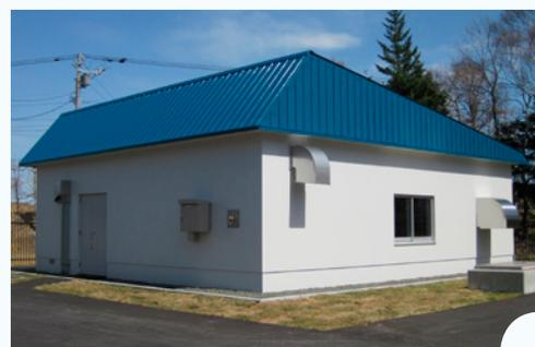
この配水池は、耐震工法で設計・施工されており、将来発生が推測されている「千島海溝沿いの巨大地震」に耐えうる構造となっています。また、災害等の断水時に生活用水を確保するための「緊急遮断弁」と火災発生時に必要とされる消防用水を供給可能とする「消防タンク車用給水ポンプ」も設置しており、有事の際は、「応急給水ポイント」として活用されます。
