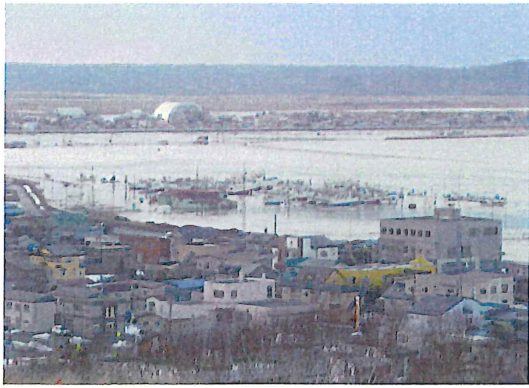
港湾用地冠水
