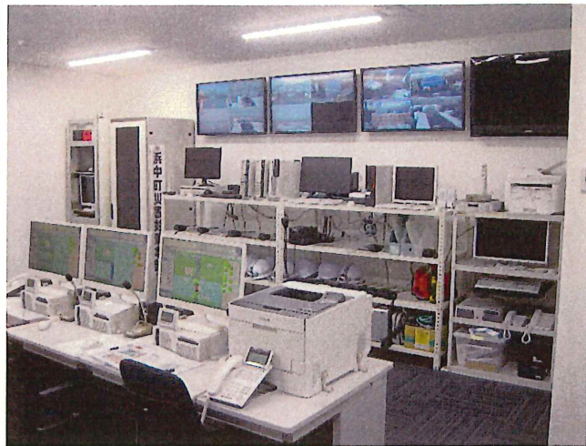
津波防災ステーション局舎（内部）
