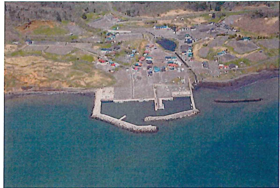
散布漁港(渡散布地区)
