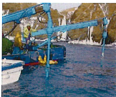
SKフープ工法による岩盤清掃
