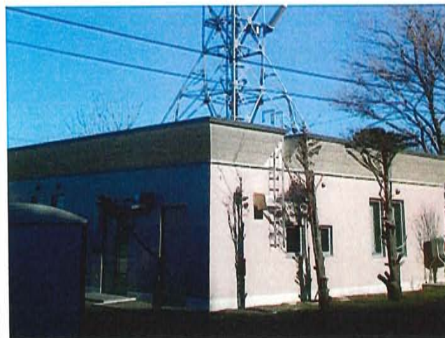
旧津波防災ステーション局舎
