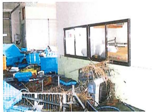
水産加工場の被害
