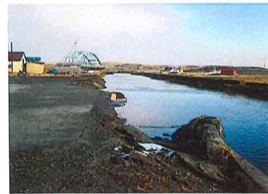
港湾施設の被害
