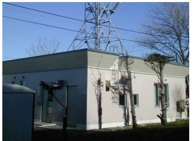
旧津波防災ステーション局舎
