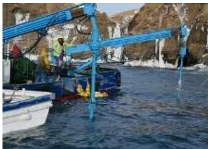
SK フープ工法による岩盤清掃
