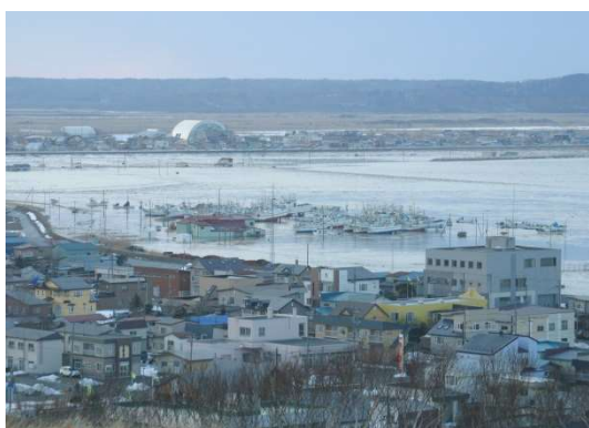
港湾用地冠水
