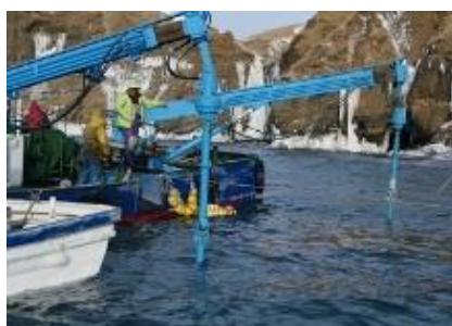
SK フープ工法による岩盤清掃
