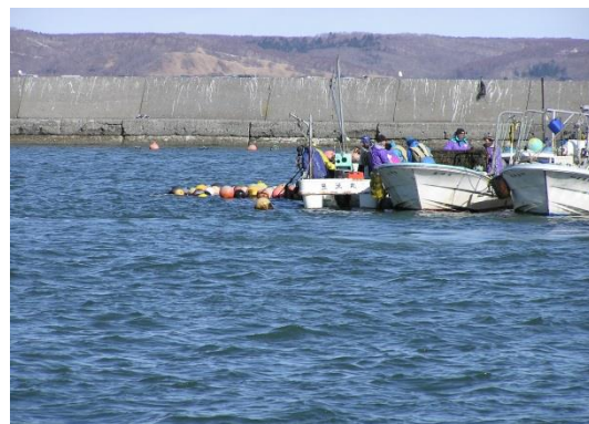
養殖施設の被害
