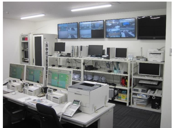
津波防災ステーション局舎(内部)
