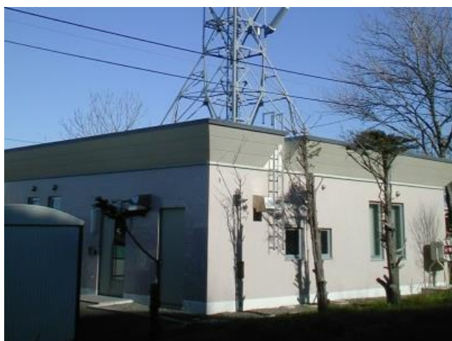
津波防災ステーション局舎
