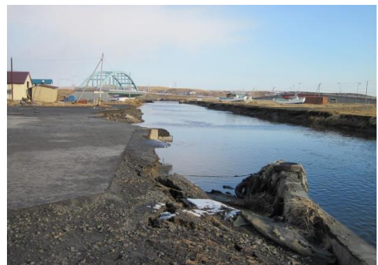
港湾施設の被害
