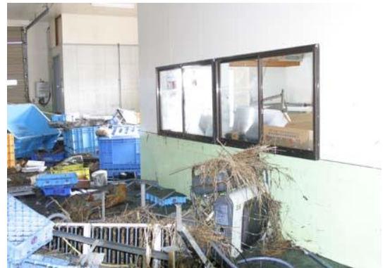
水産加工場の被害
