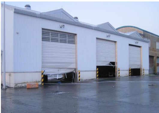
荷捌施設の被害
