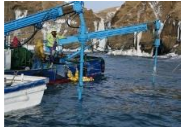
SK フープエ法による岩盤清掃
