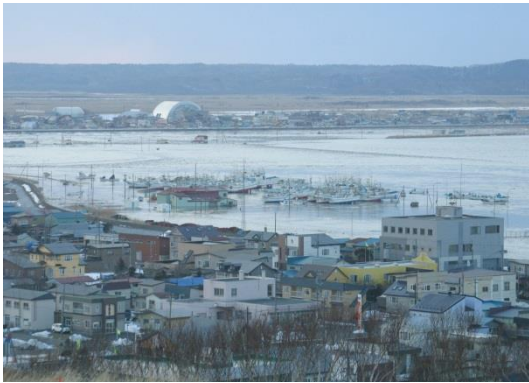
港湾用地冠水
