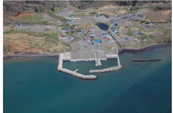
散布漁港(渡散布地区)
