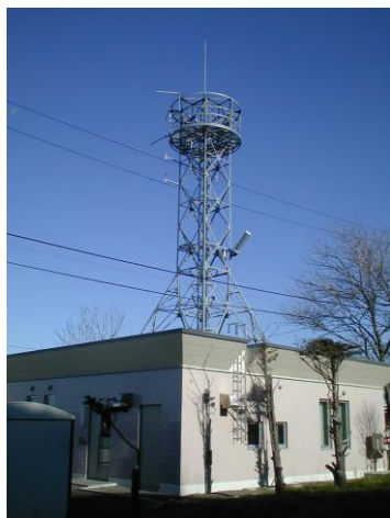
津波防災ステーション局舎
