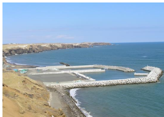
散布漁港(渡散布地区)
