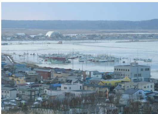
港湾用地冠水
