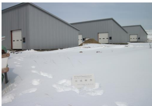
漁労設備保管施設
