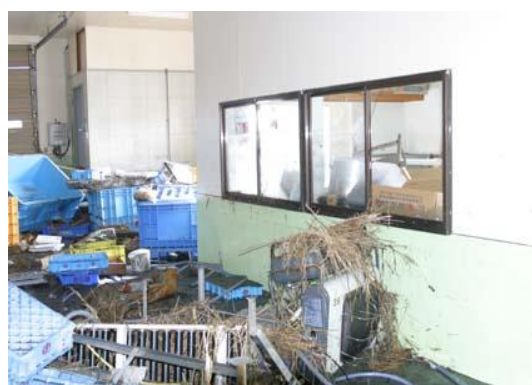
水産加工場の被害
