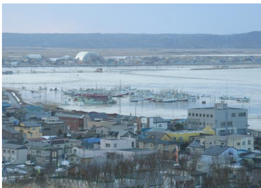
港湾用地冠水
