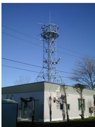
津波防災ステーション局舎
