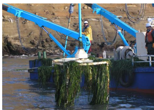
SKフープ作業風景
