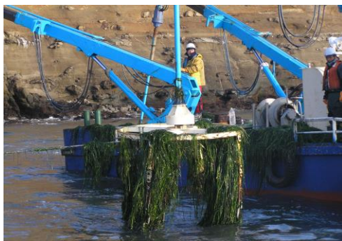
S K フープ作業風景
