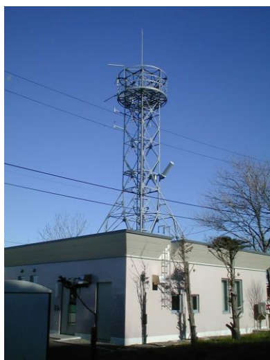
津波防災ステーション局舎
