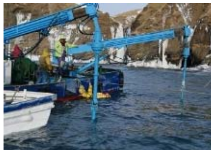
SK フープエ法による岩盤清掃
