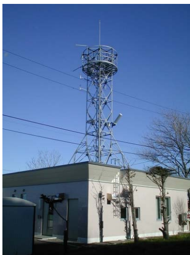
津波防災ステーション局舎
