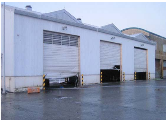
荷捌施設の被害
