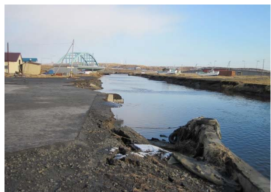
港湾施設の被害
