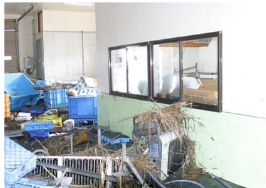
水産加工場の被害
