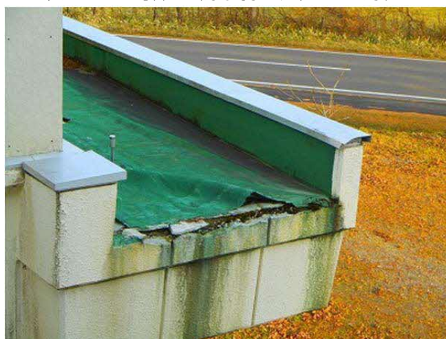
b.茶内第一小学校 体育館 築年数：34年 屋根屋上：C評価 防水剥がれ、CON劣化
