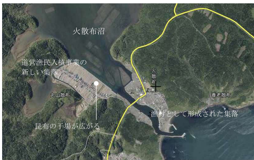
■ 上空からの散布市街の様子
