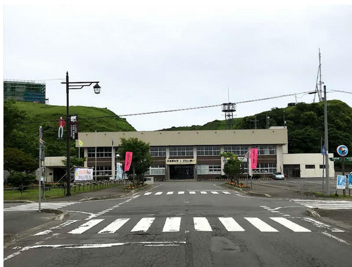
図 4-5 役場旧庁舎外観写真
