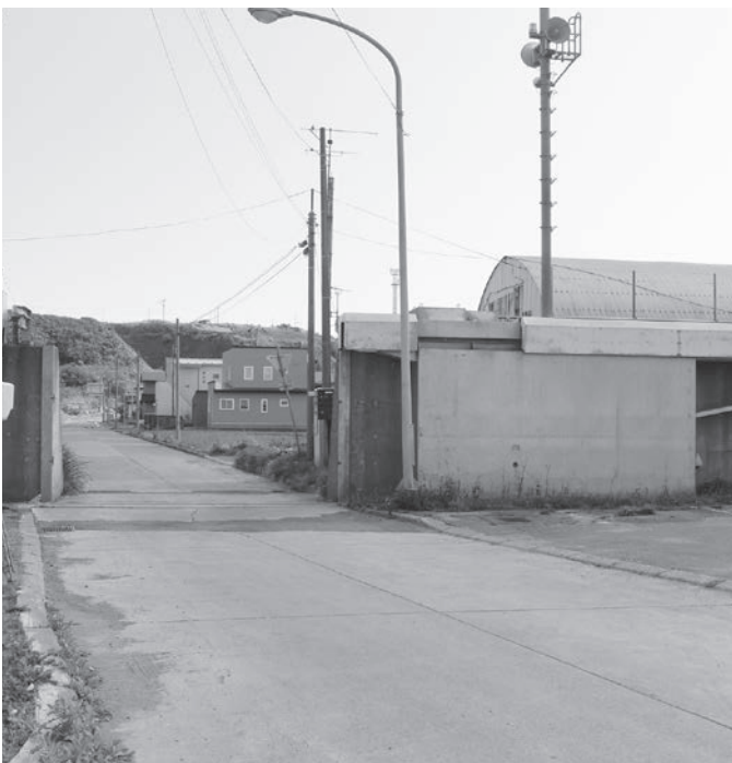
高上改良される陸間 (1号基)
