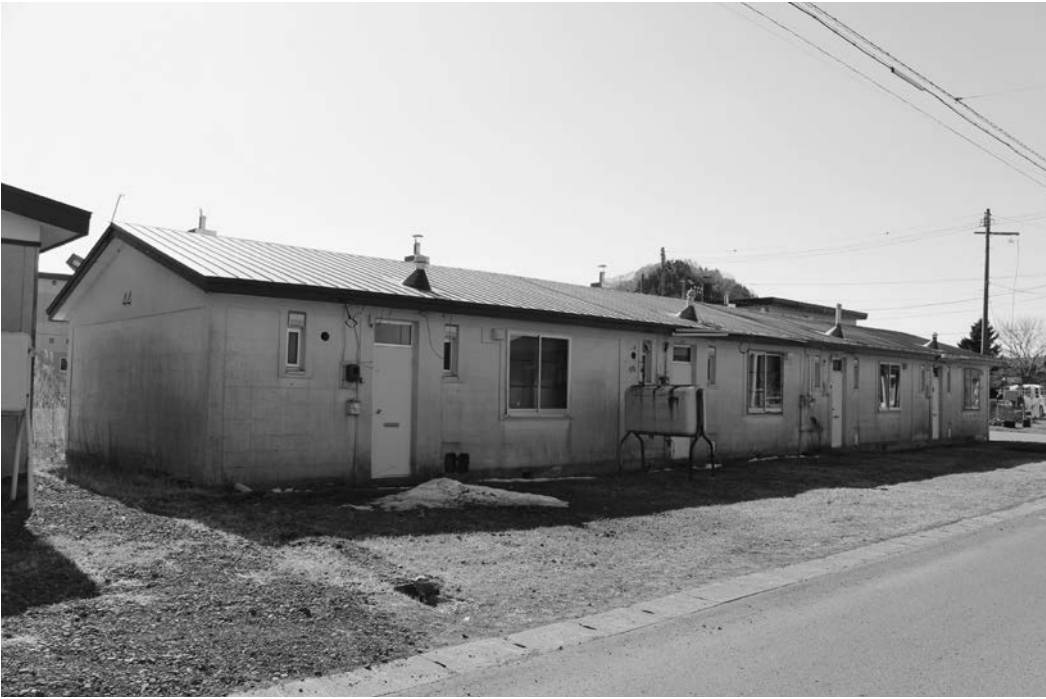
解体される町営住宅
