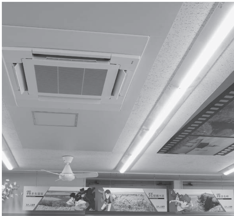
小規模事業継続支援補助で改修した天井の空調など
