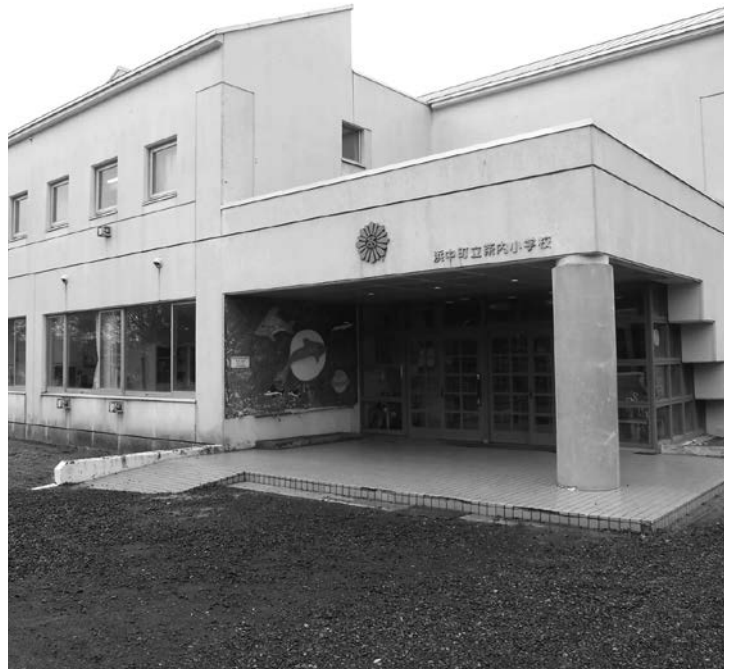
雨漏りが発生している茶小校舎
