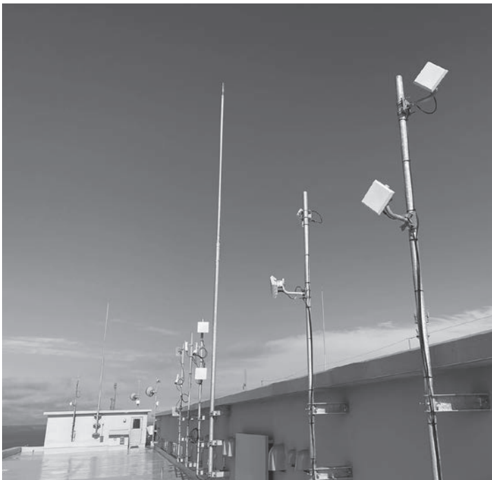
庁舎屋上のアンテナ群
