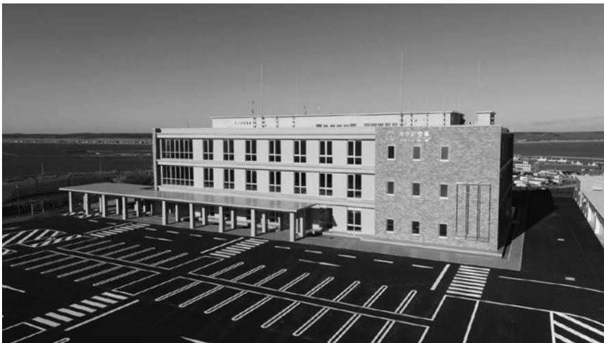
防災機能を備えた新庁舎の全景
