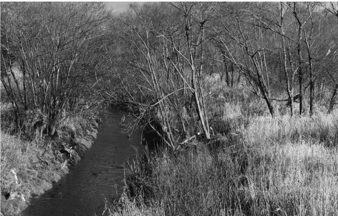
伐採される支障木（ノコベリベツ川）
