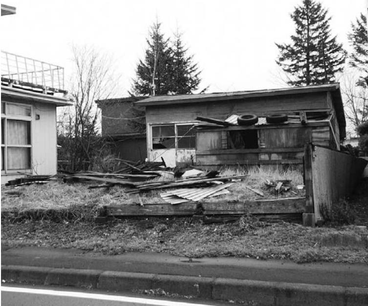
台風により飛散した空き家敷地内
