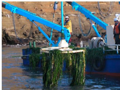
SK工法による 雑海藻駆除風景
