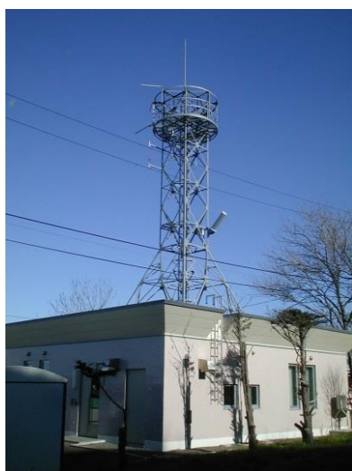
津波防災ステーション局舎
