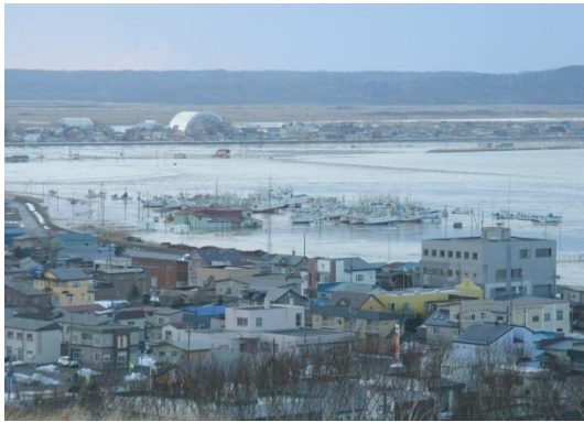
港湾用地冠水
