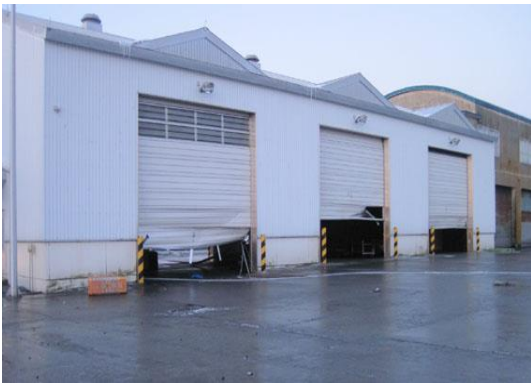
荷捌施設の被害
