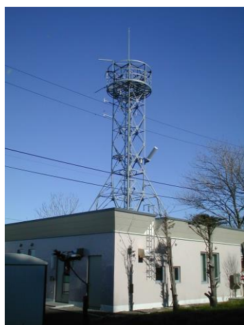
津波防災ステーション局舎
