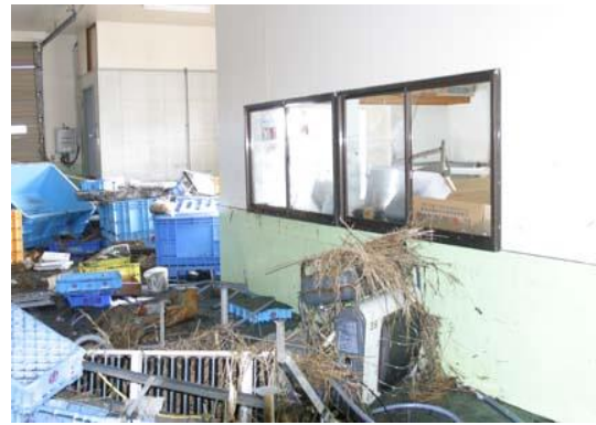
水産加工場の被害
