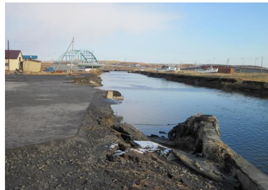
港湾施設の被害
