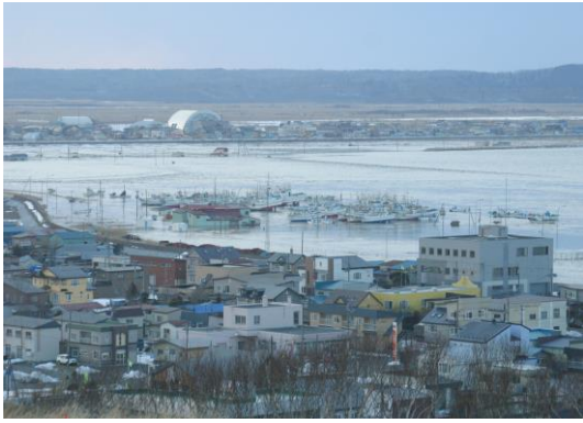
港湾用地冠水
