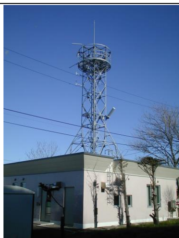
津波防災ステーション局舎
