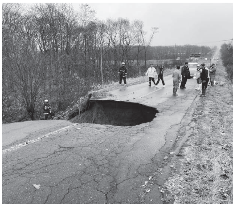
陥没した茶内1号幹線道路
