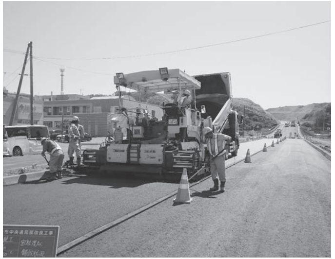
道路工事の様子
