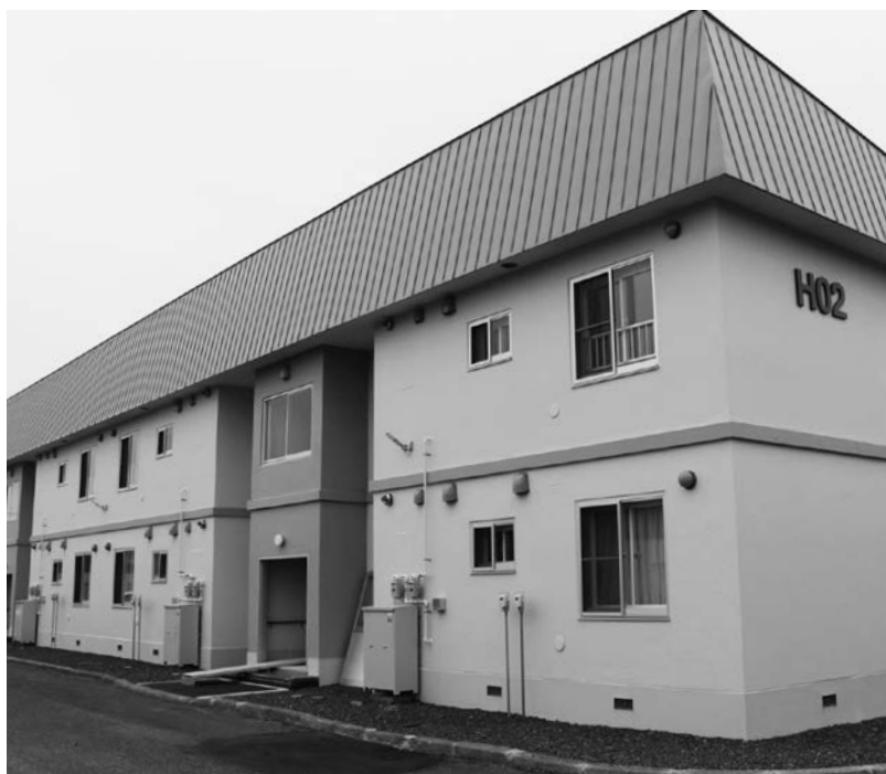
改善工事が実施された霧多布H団地
