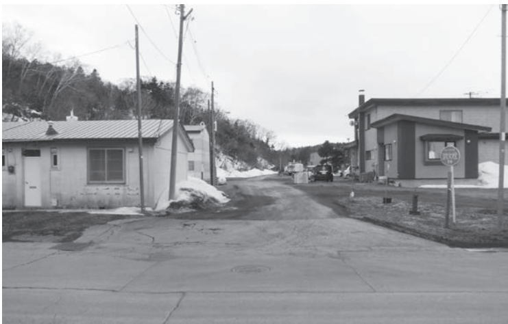
整備が待たれる丸山散布避難道入口
