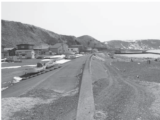
嵩上げされる水取場防潮堤
