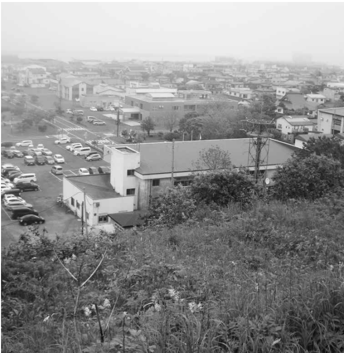
老朽化が進み、耐震性に不安が!!
